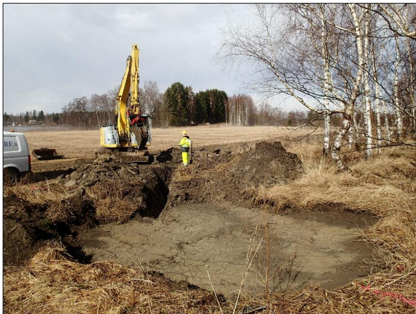
Muuntamaa varten avattu alue peltokerroksen alatasoon kaivettuna.
