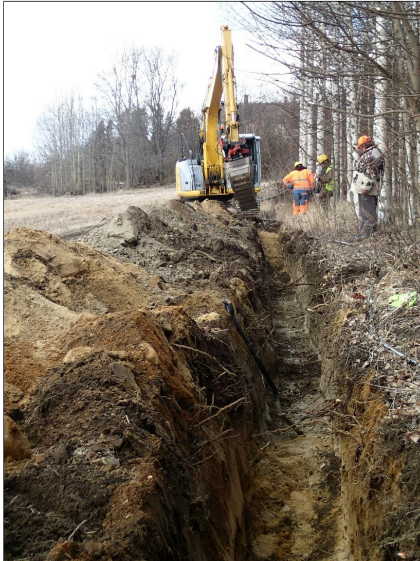
Työkuva. Kaapeliojaa avataan valvonnassa Vesunnan pihapiirin kaakkoispuolella. Kaakosta.
